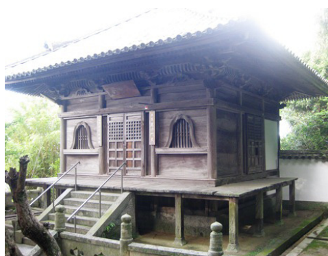
③① 毘沙門堂の三方の扉をリニューアルしました。隙間だらけで、台風が来るときまて雨が降り込むので、畳を上げていました。むろん右が旧、左が新。
