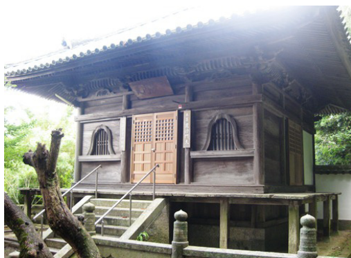
③① 毘沙門堂の三方の扉をリニューアルしました。隙間だらけで、台風が来るときまて雨が降り込むので、畳を上げていました。むろん右が旧、左が新。
