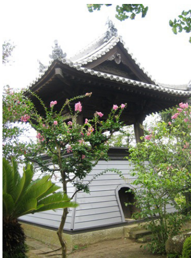
③③ 鐘楼は、袴の部分を葺き直しました。トタンの波板（上）から、庫裏の屋根に合わせてガルバニウム仕上げ（下）。
